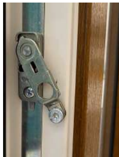
pojistka proti otočení kliky
