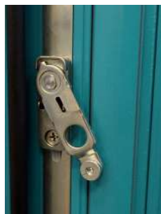
pojistka proti otočení kliky
